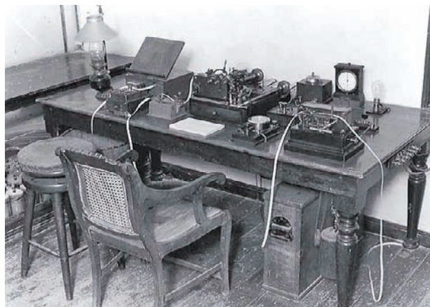
■写真6. ケーブル陸揚げ局 建物内部
