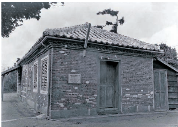
■写真5. 長崎県小ヶ倉のケーブル陸揚げ局
