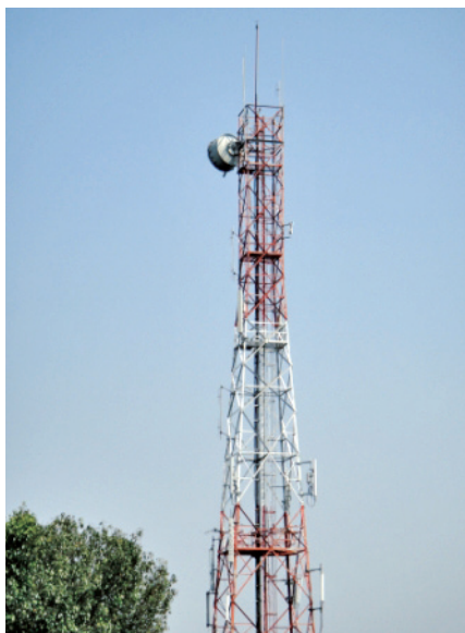
■写真. マイクロ波固定無線によるモバイルバックホールの例
